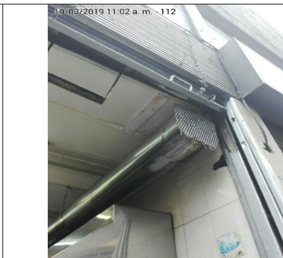
Fotografía No. 6 Punto de desfogue del ducto.
