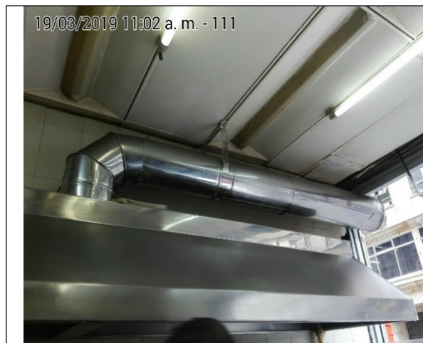
Fotografía No.5 Sistema de extracción y tramo del ducto.
